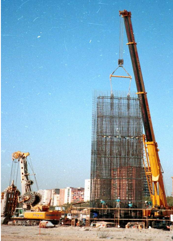
Fig 9 Installazione delle gabbie d'armatura
