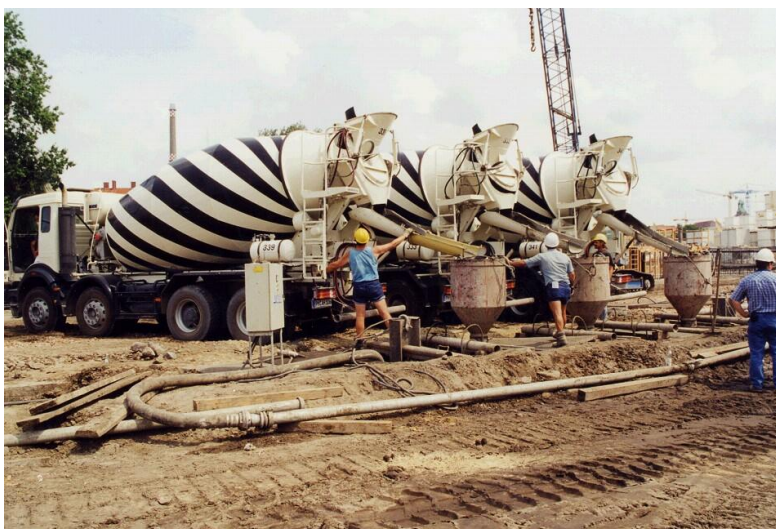
Fig 10 Getto del calcestruzzo
