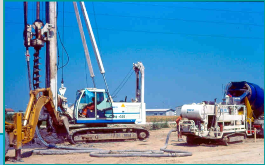
Cantiere TAV PALI CFA
