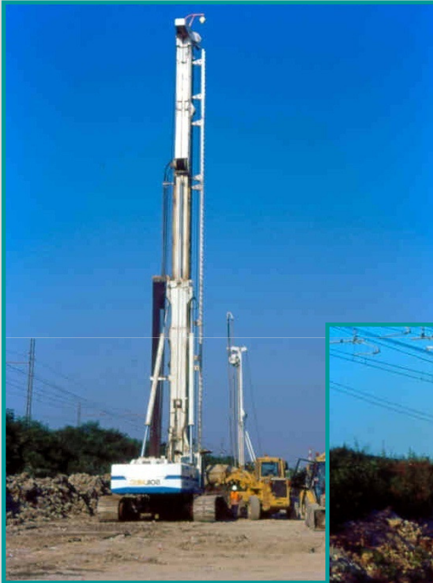
Cantiere TAV PALI CFA
