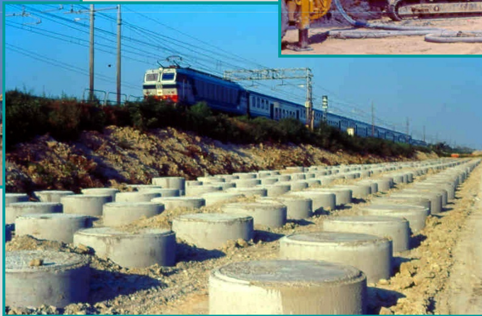
Cantiere TAV CAPPELLOTTI SU PALI CFA
