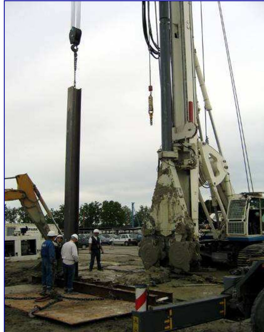
Inserimento putrelle di armatura
