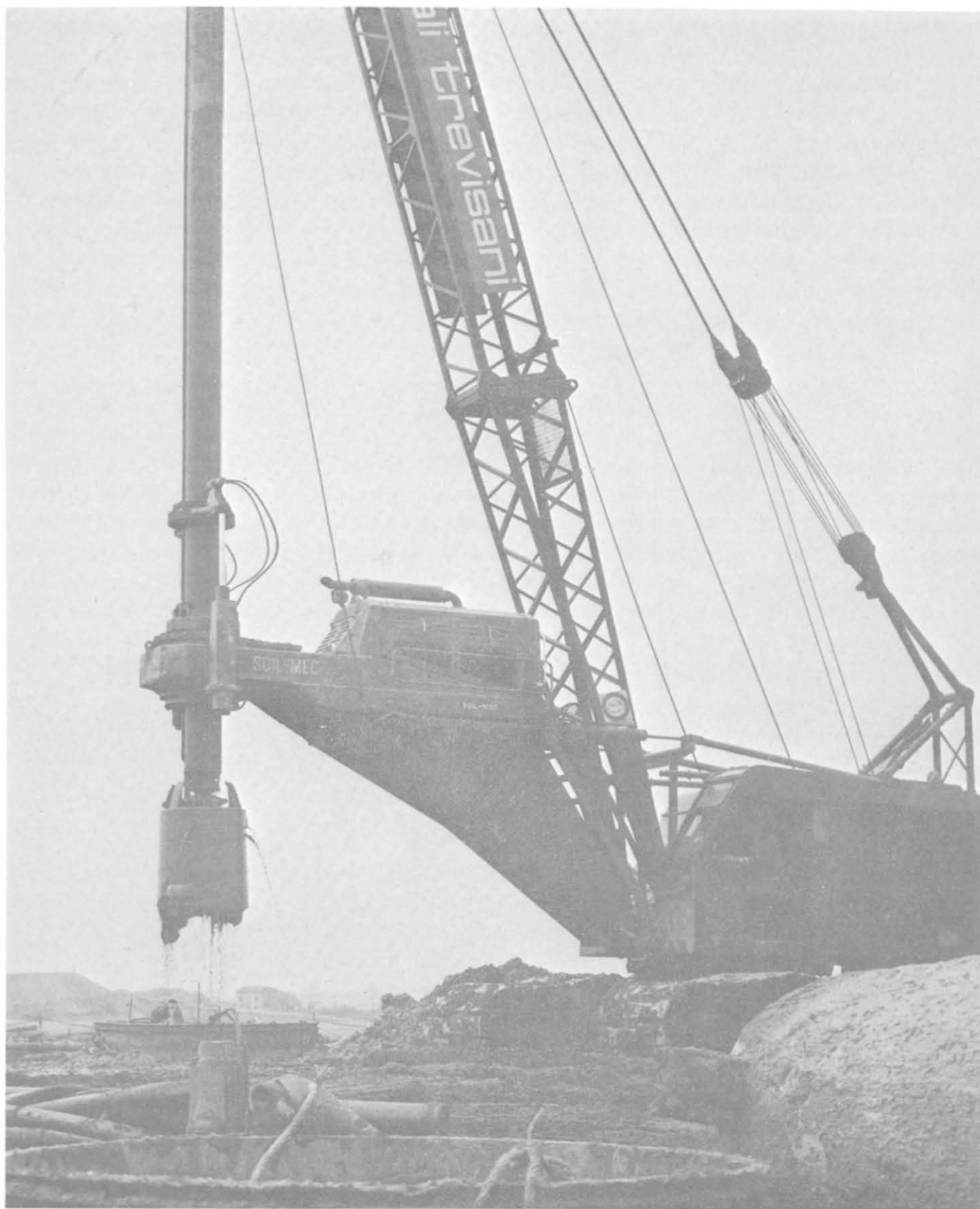
Fig. 6-12 - ENEL (a Sermide): N. 1100 pali \phi 1000 profondità 35 m. Macchina: RT3/S (Pali Trevisani).
