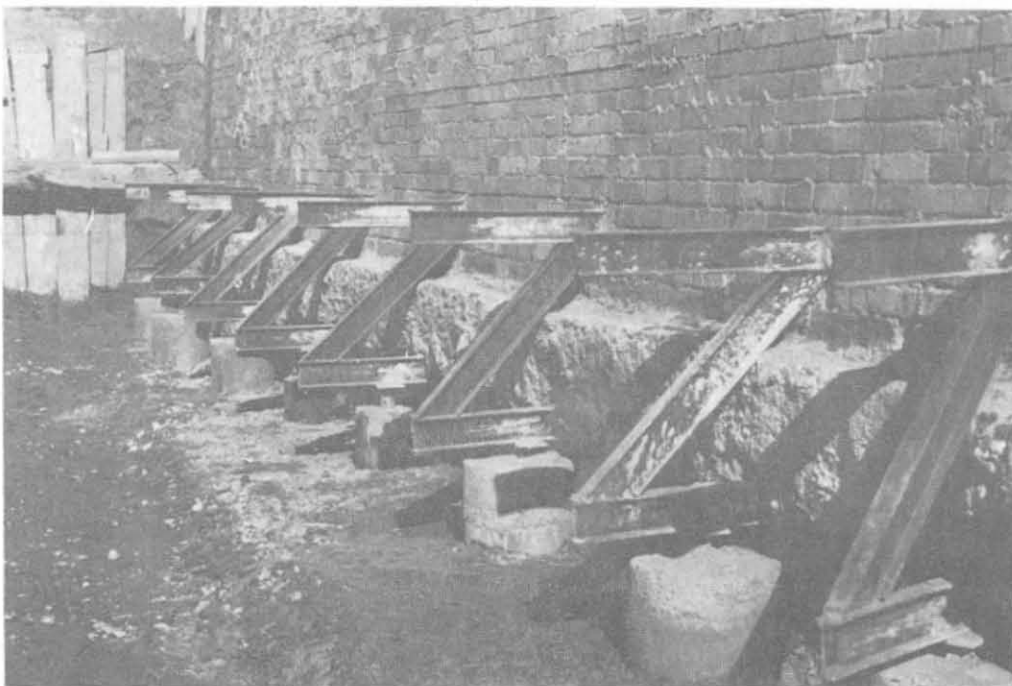
Fig. 7-12 - Pali di sottofondazione eseguiti utilizzando come contrasto mensole di ferro (Fondacem).
