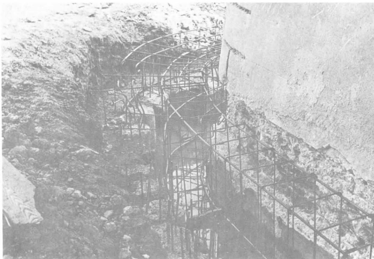
Fig. 8-8 - Tura di pali tri- vellati intorno ad una pila (Fondacem).
