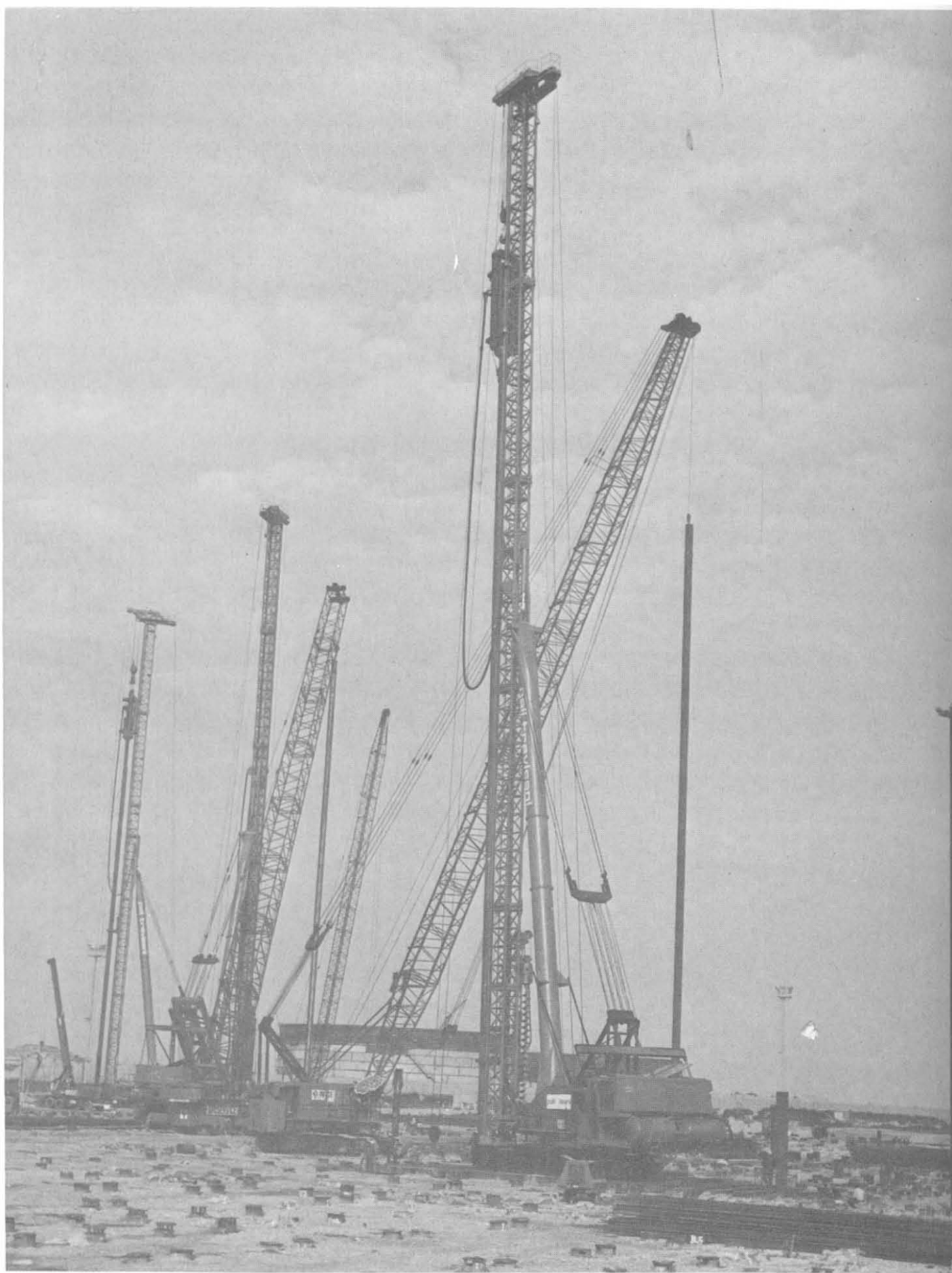
Fig. 5-3 - Cantiere: ENEL di Porto Tolle (Pali Trevisani SpA). La macchina: MBV con maglio Vulcan 030.
