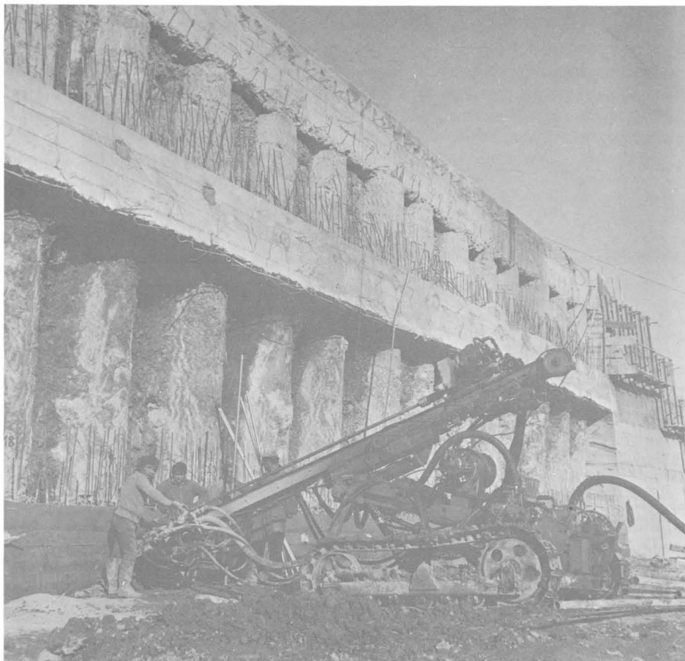
Fig. 8-15 - Diaframma con pali trivellati, discontinuo.
