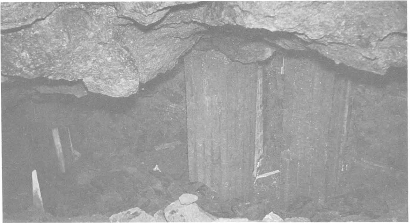
Fig. 4-33 - Attraversamento di una galleria con pali trivellati.
