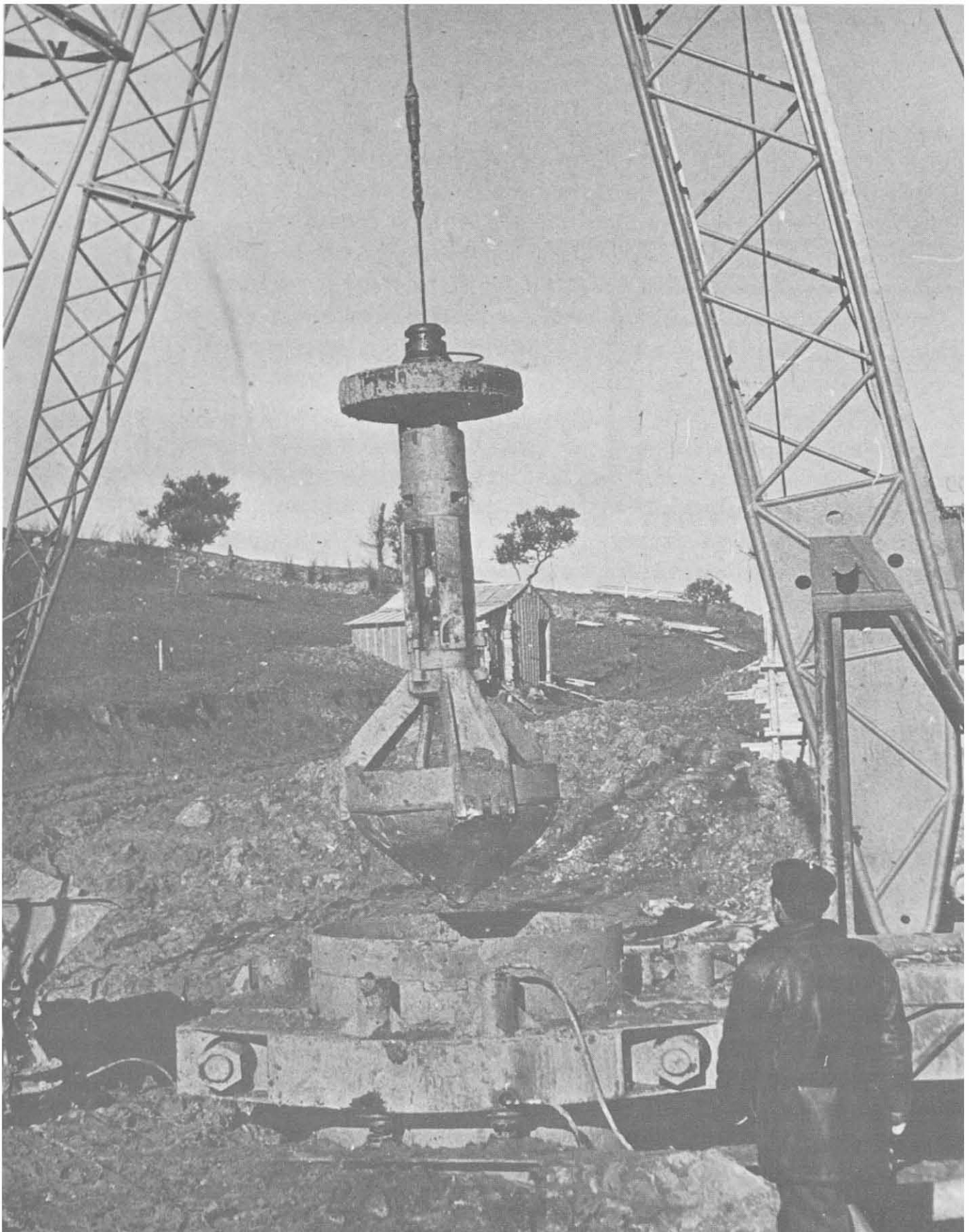
Fig. 6-3 - Primo tipo di attrezzatura Benoto in azione.
