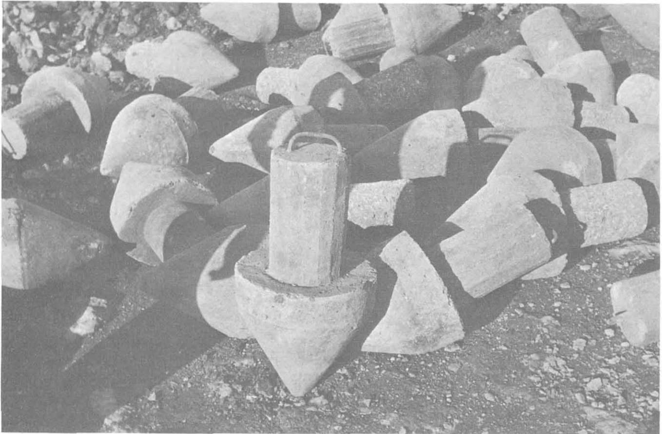
Fig. 7-15 - Puntazze di calcestruzzo per l'infissione del primo elemento cilindrico.
