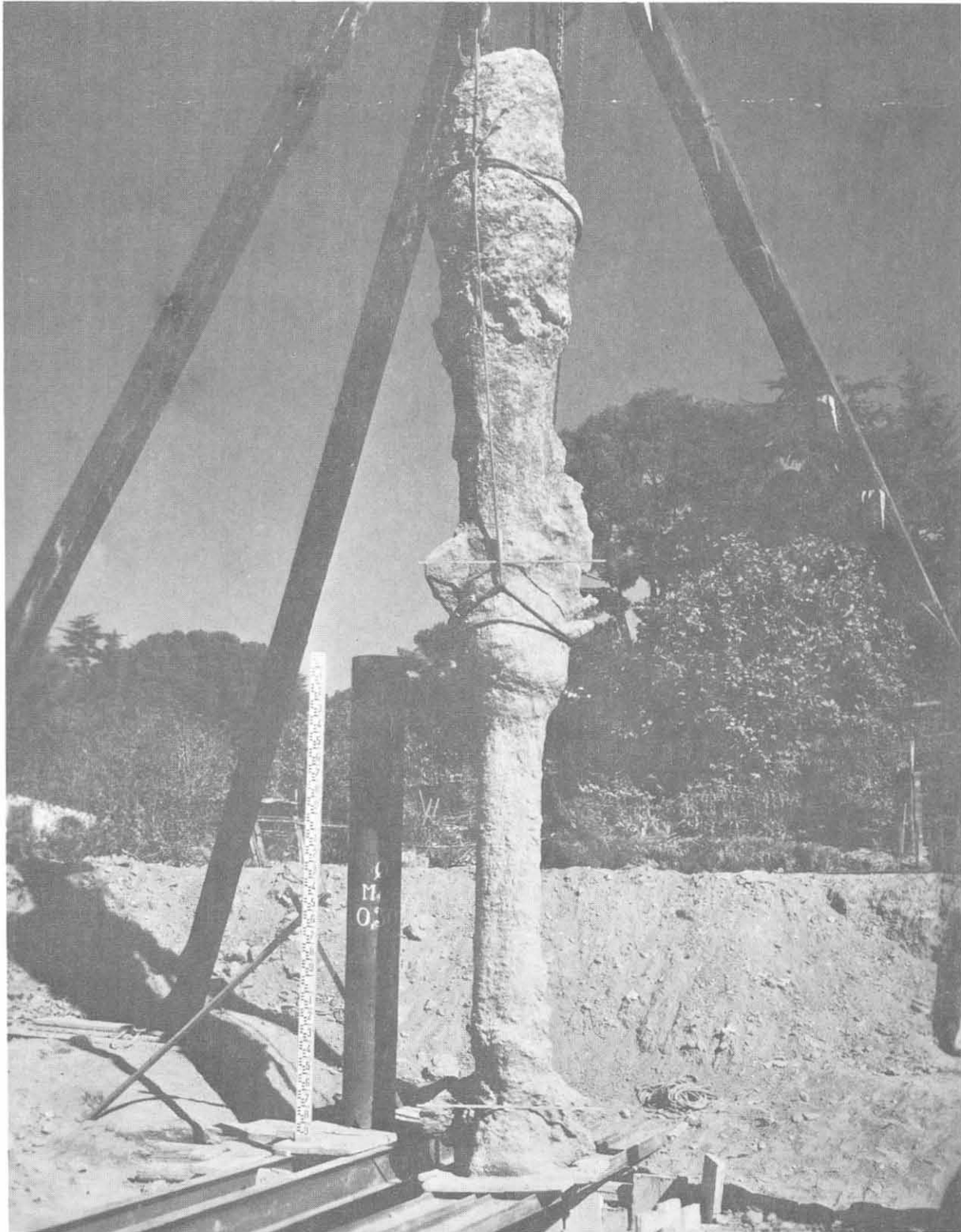
Fig. 4-27 - Palo tipo SACOP estratto dal terreno.
