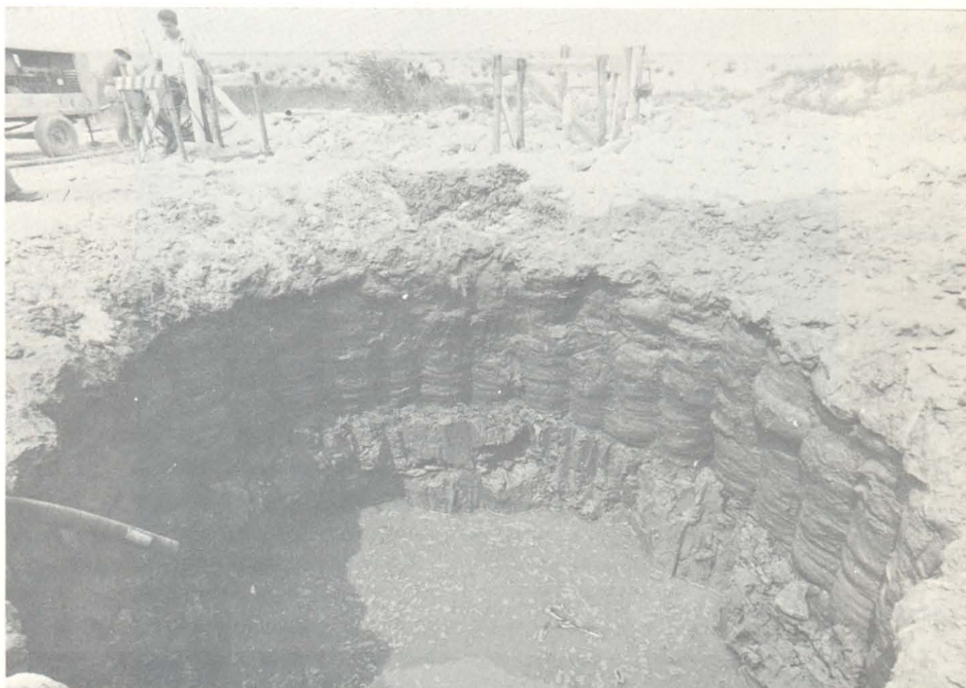
Fig. 6-24 - Colonne CCP per la formazione di un pozzo.
