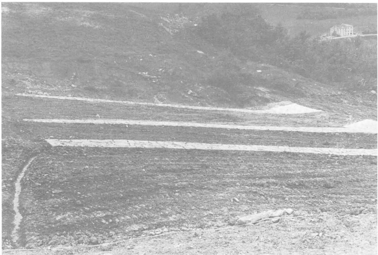
Fig. 19-17 - Speroni drenanti a consolidamento di una pendice naturale (Fondacem).
