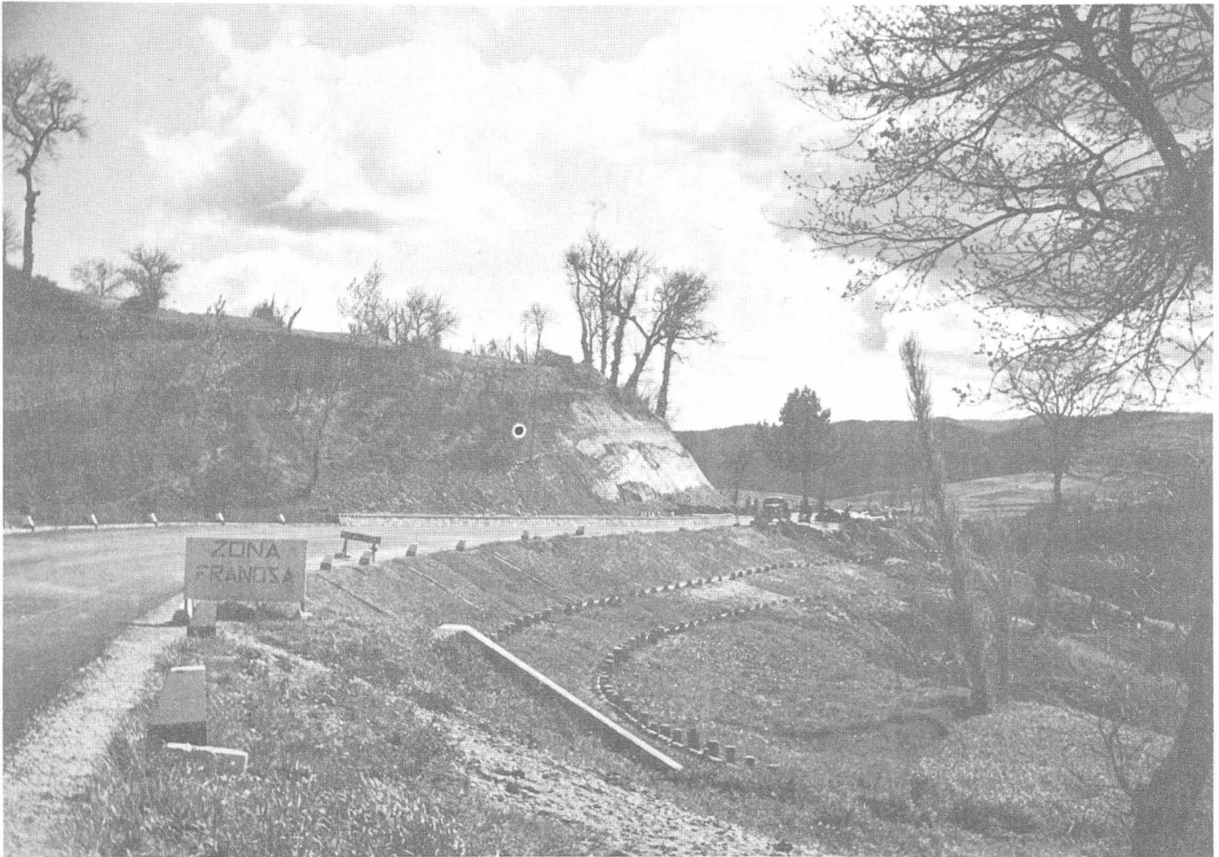
Fig. 3-2 - Pali in legno impiegati per il consolidamento di una scarpata.
