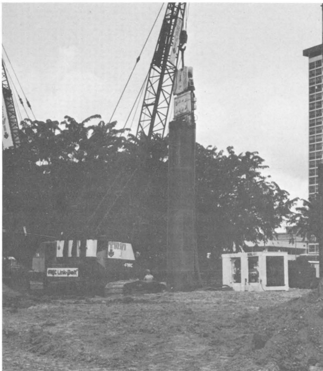
Fig. 10-9 - Estrazione di un tubo con vibratore della serie VS (Soilmec della Trevi SpA, Cesena).
