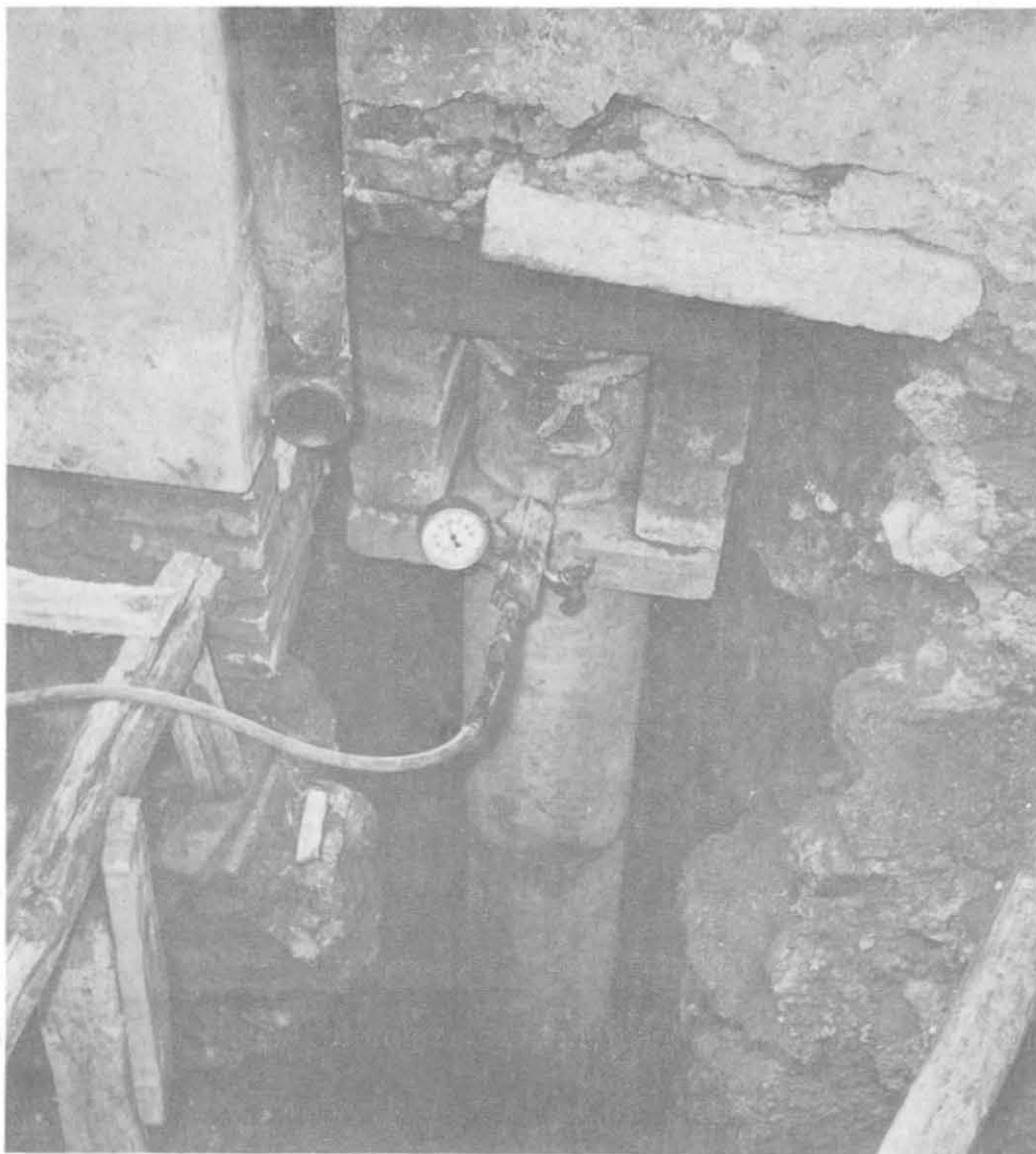
Fig. 7-11 - Esempio di palo di sottofondazione a diretto contrasto delle murature.
