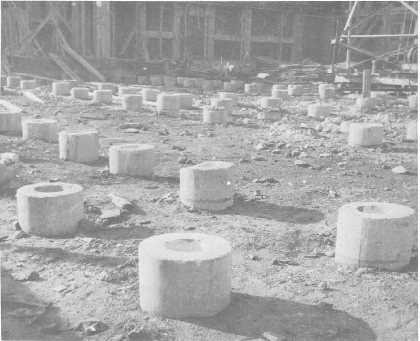
Fig. 4-10 - Fondazione su piloti SCAC.
