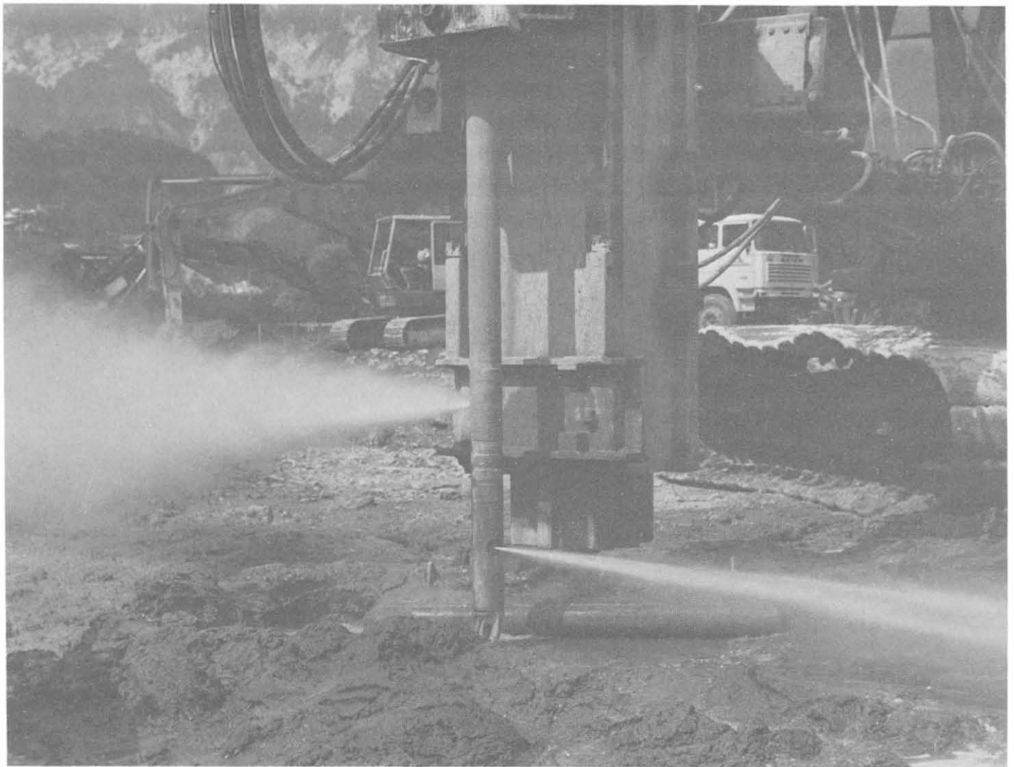
Fig. 6-23 - Perforazione ed iniezione sistema CCP.
