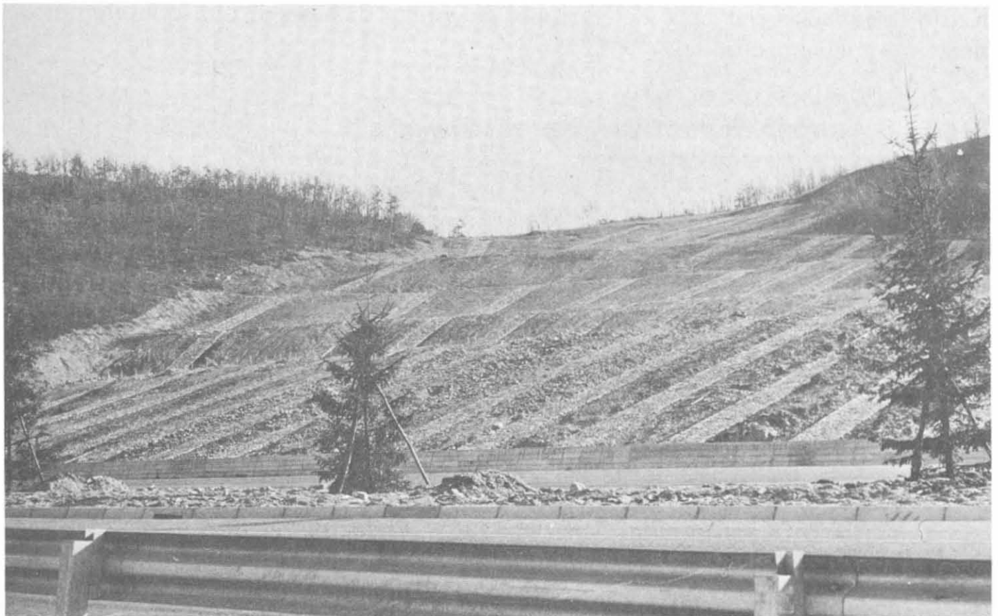
Fig. 19-22 - Autostrada della Cisa. Frana consolidata con speroni drenanti.
