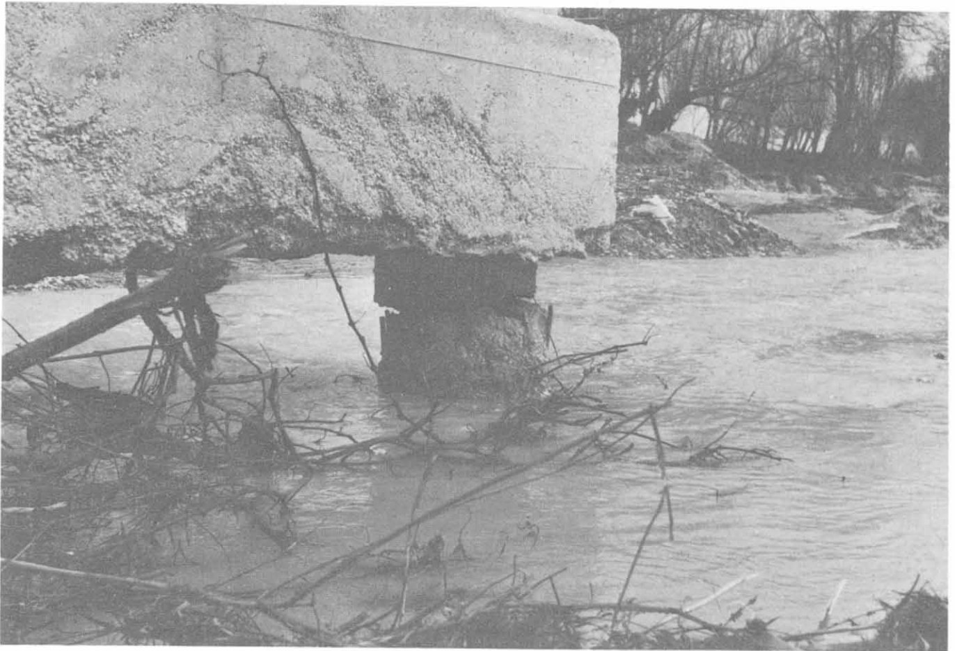
Fig. 22-10 - Scalzamenti ed interruzione di getto.
