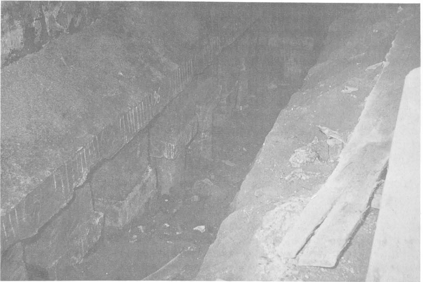
Fig. 7-13 - Pali di sottofondazione con elementi di calcestruzzo (Fondacem).
