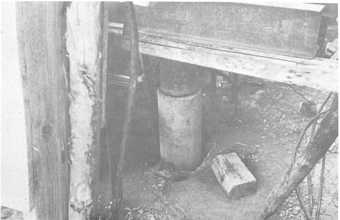
Fig. 7-14 - Sottofondazione con pali pressoinfissi in fori predisposti.
