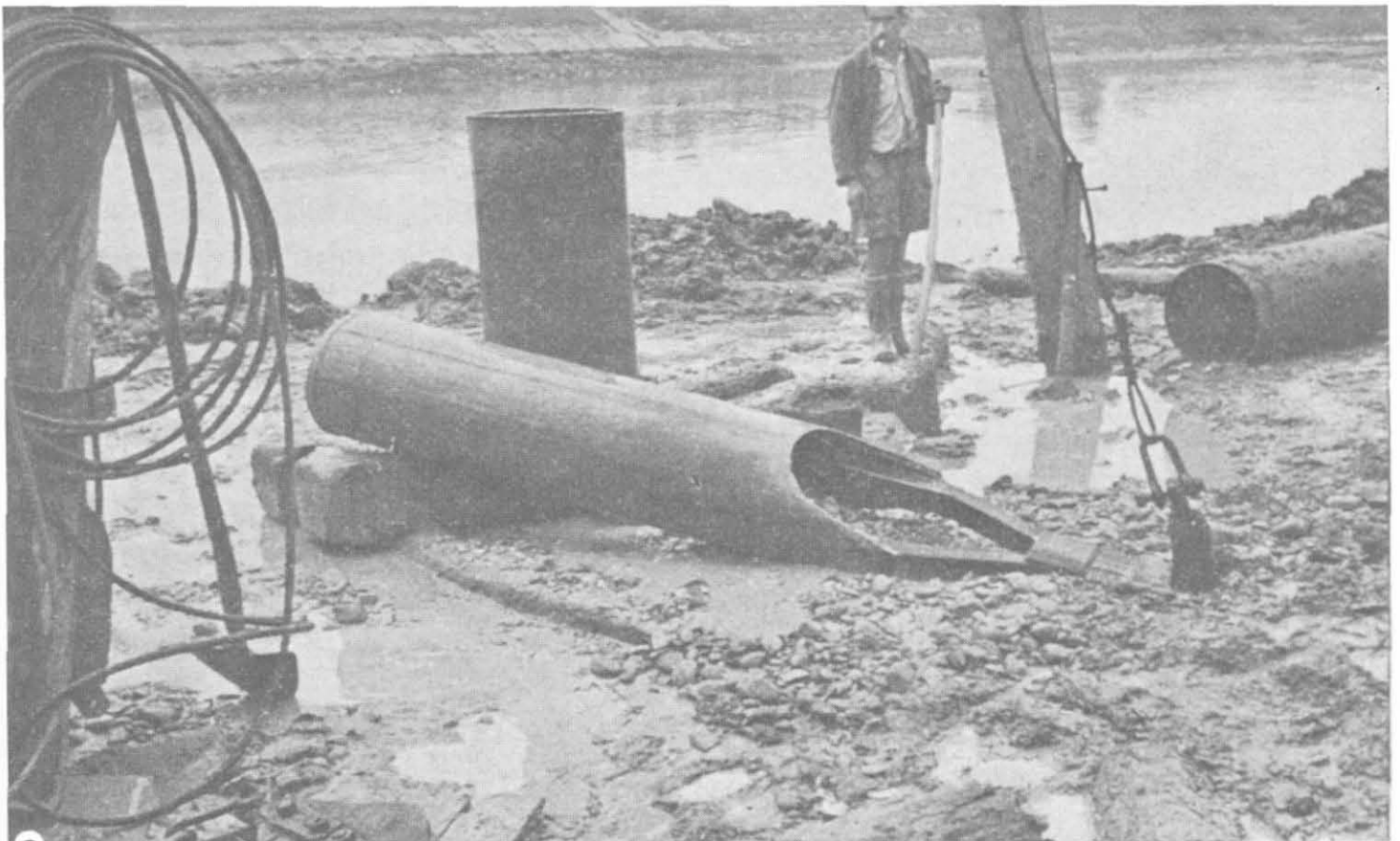
Fig. 4-21 - Tipo di cucchiaia per pali trivellati (Fondacem Srl, Roma).
