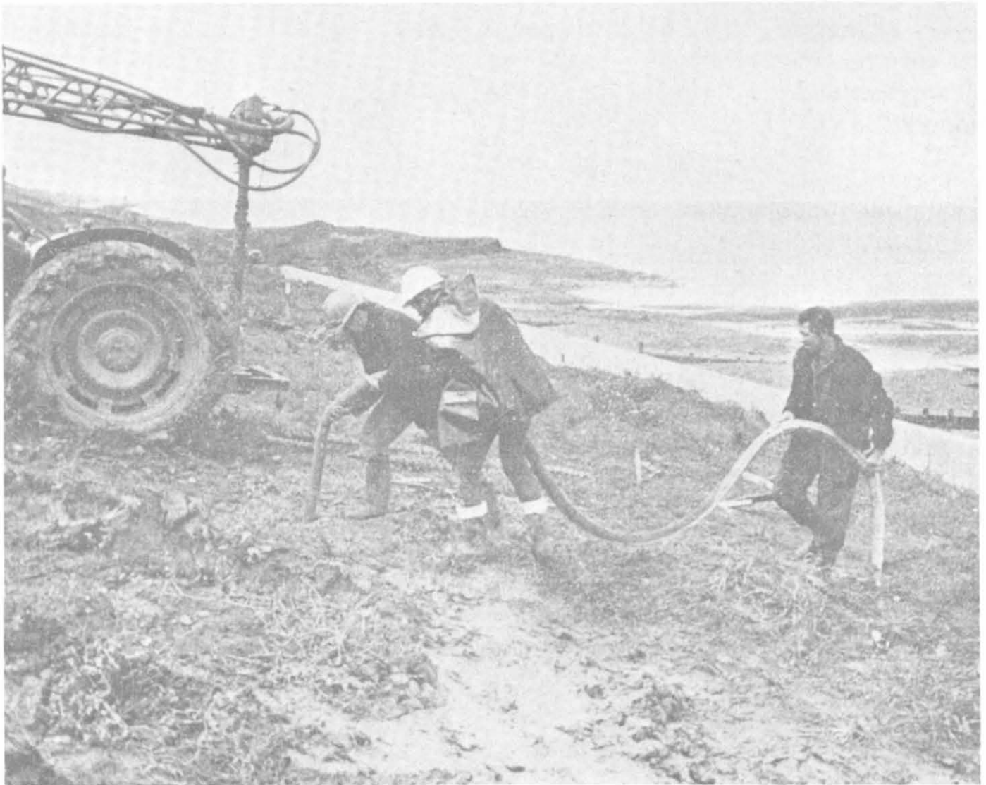
Fig. 7-30 - Posa di dreni Sandwich (Cementation).
