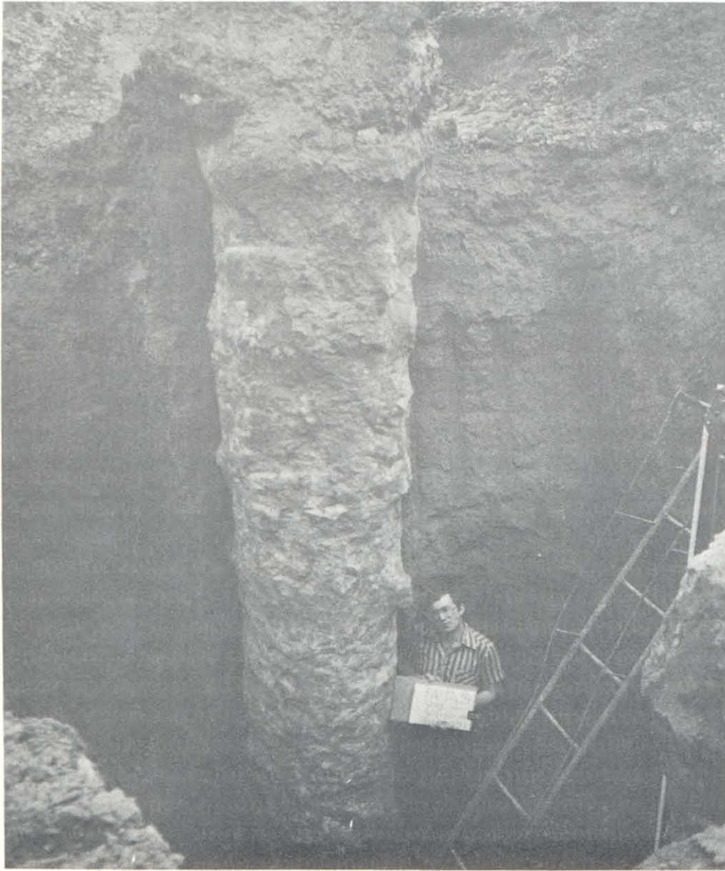
Fig. 6-25 - Colonna isolata (Rodio) in un campo prova a Volgodonsk (Urss).
