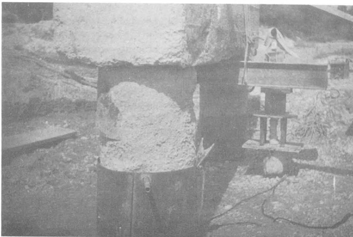
Fig. 22-11 - Ripristino del palo.
