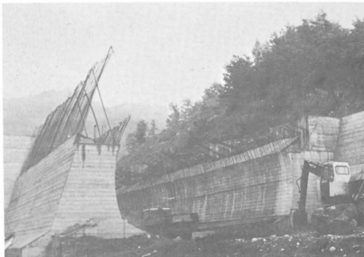
Fig. 19-20 - Lavori di completamento della galleria della figura precedente (Autostrada della Cisa).
