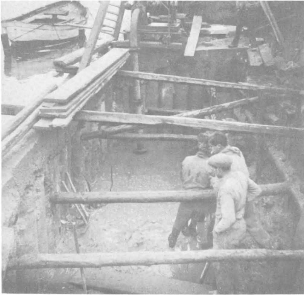
Fig. 8-10 - Tura di pali trivellati per la fondazione di una pila di un ponte.
