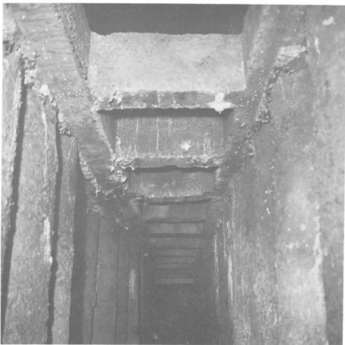
Fig. 8-19 - Cunicolo di scarico del diaframma drenante della fotografia precedente (Fondacem).
