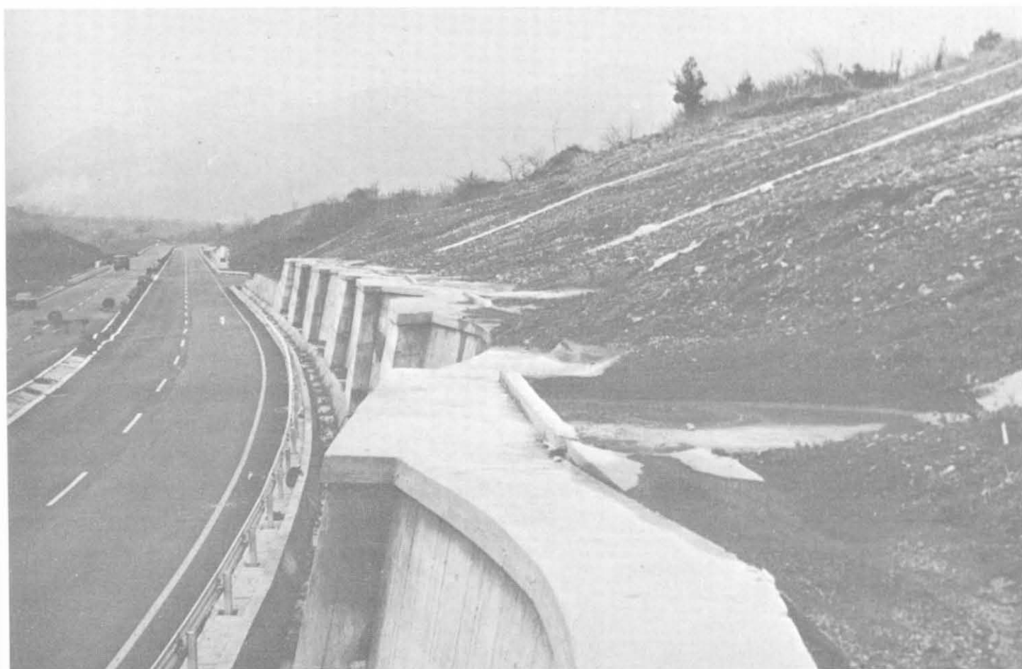
Fig. 19-18 - Autostrada Salerno-Reggio Calabria. Speroni drenanti con testate a pozzo.
