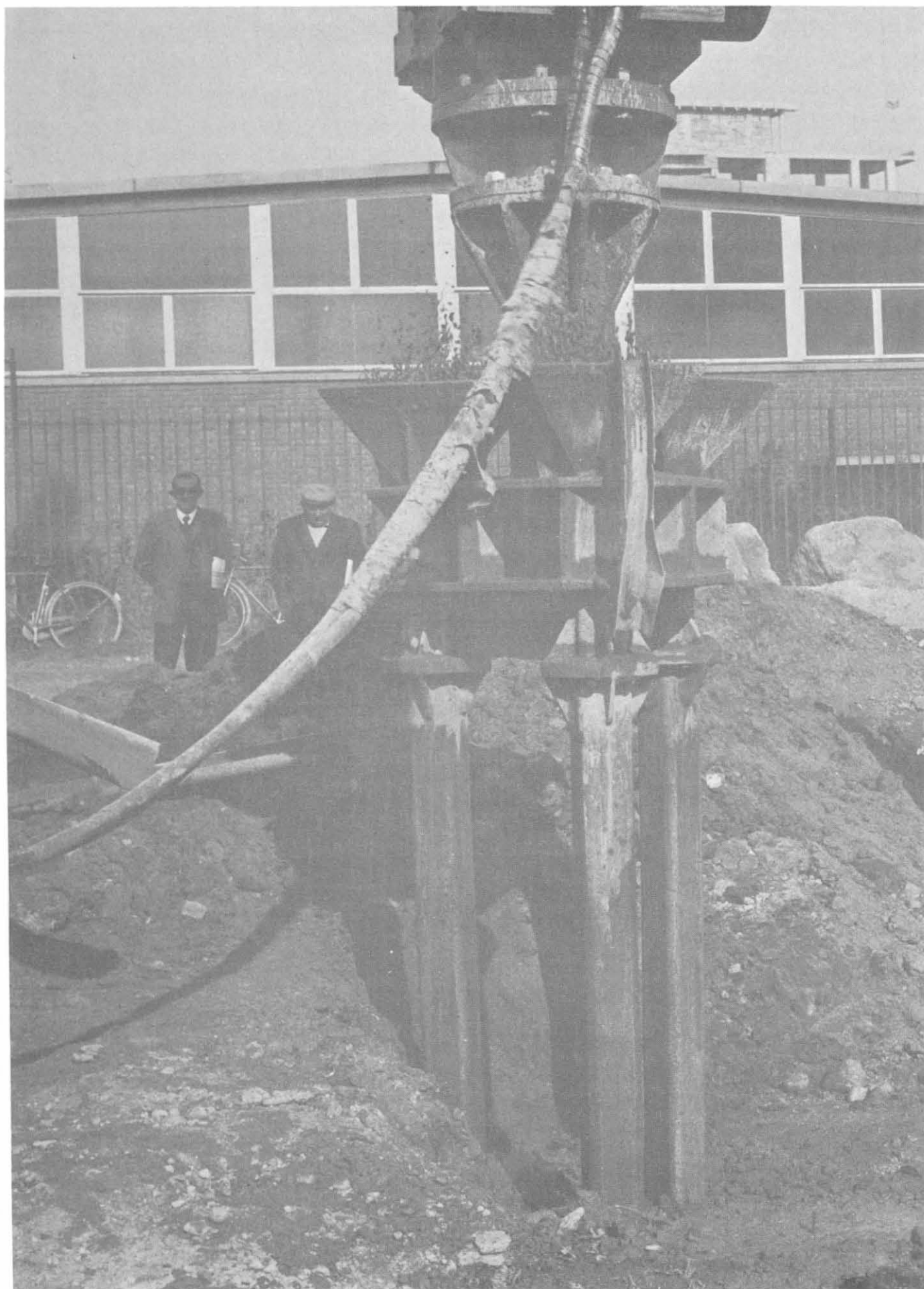
Fig. 7-26 - Fase di getto dei fori realizzati dalle colonne vibranti (Presspali).
