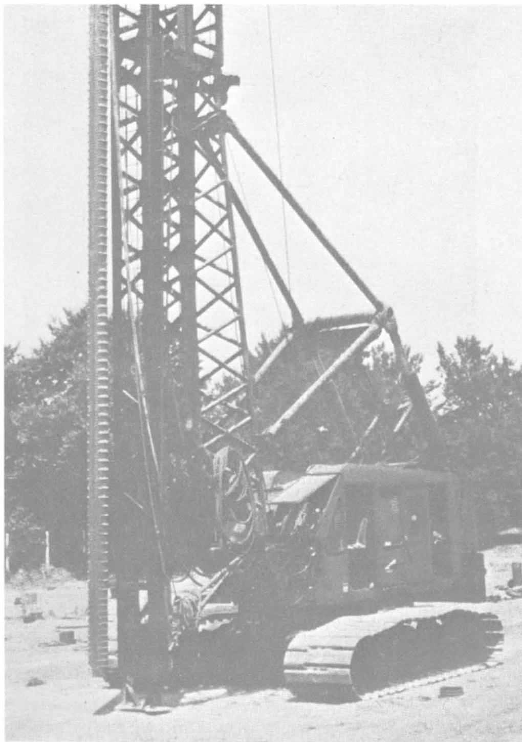
Fig. 7-10 - Mandrino ad espansione attrezzatura Lacor.
