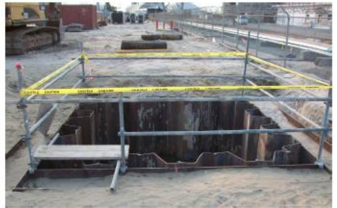
Cofferdam con palancole da 22 metri
