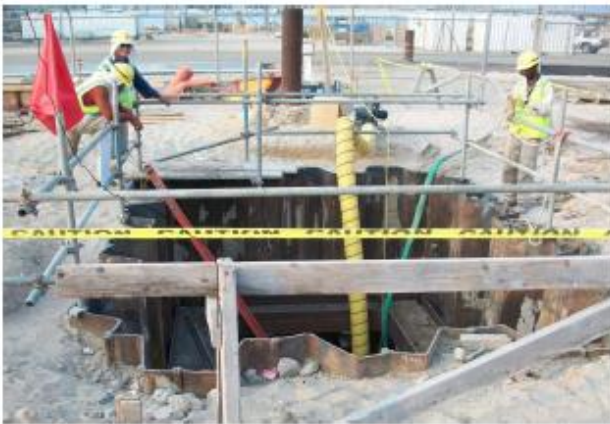
Cofferdam con palancole da 16 metri
