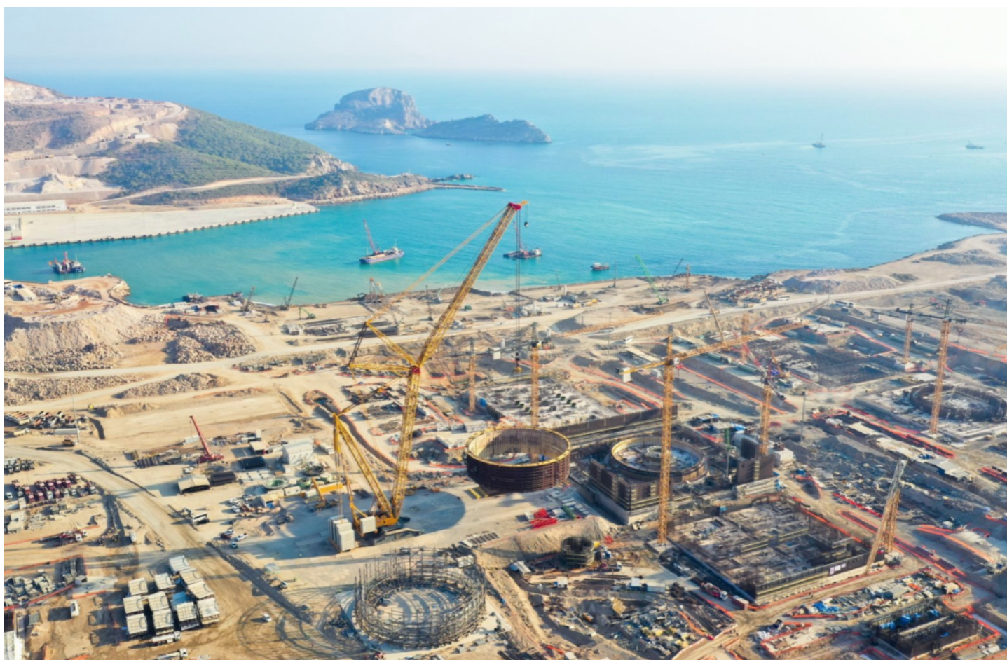
Janvier 2021. Construction de la centrale turque à Akkuyu. Cette centrale, devant démarrer sa production en 2026, doit à terme produire 10% de l'électricité turque et sera exploitée entièrement par la société russe Euratom
