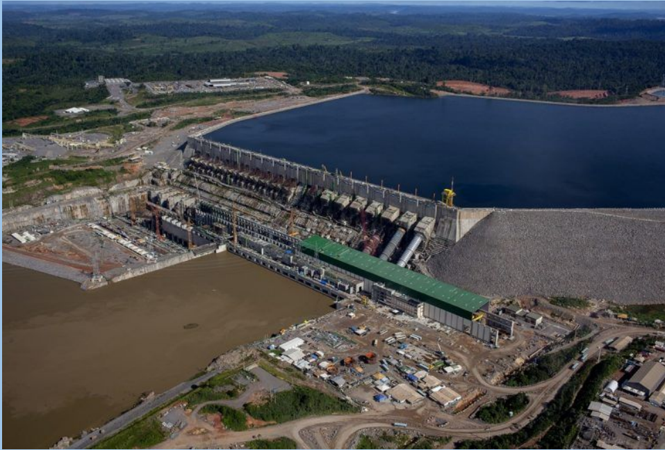
L'un de 6 barrages de la Centrale Hydroélectrique de Belo Monte
