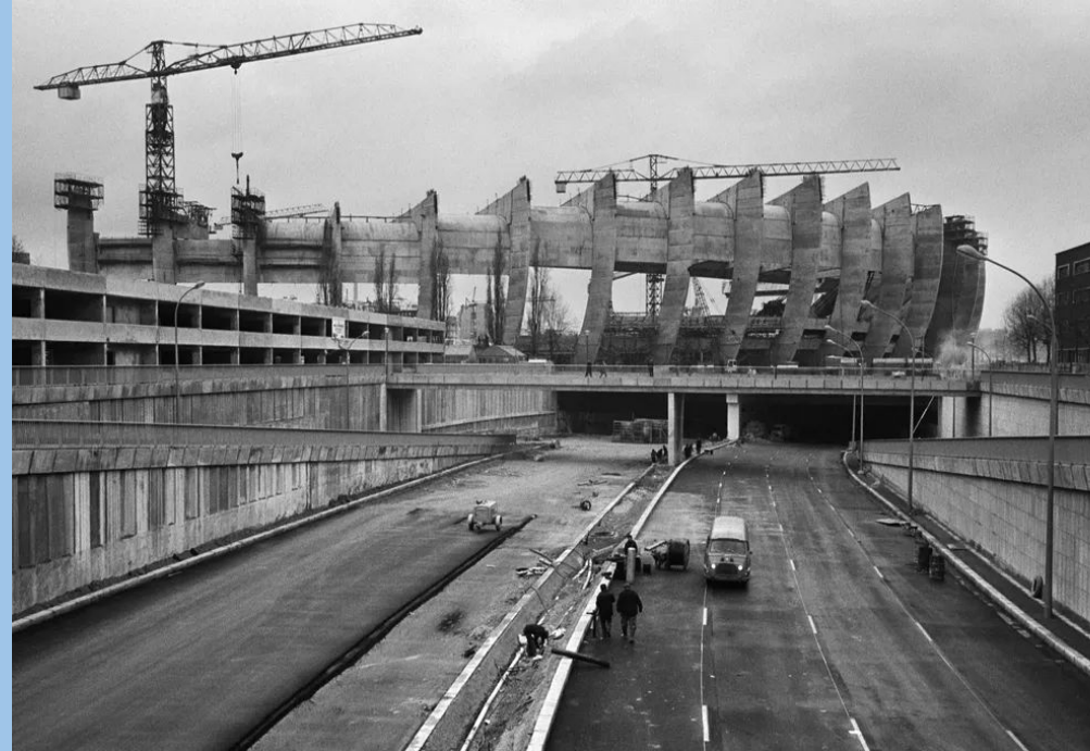
Construction du périphérique en 1973
