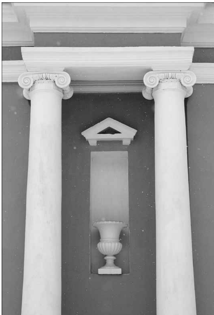
Рис. 1. Дом № 5 по ул. Свердлова. Фрагмент фасада.
