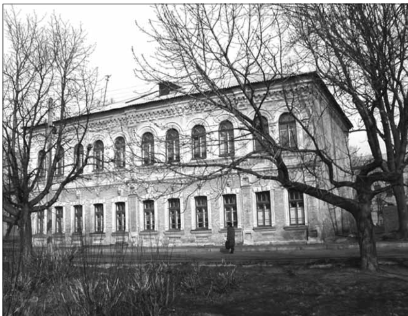
Рис. 4. Дом № 3 по ул. Сакко и Ванцетти.
